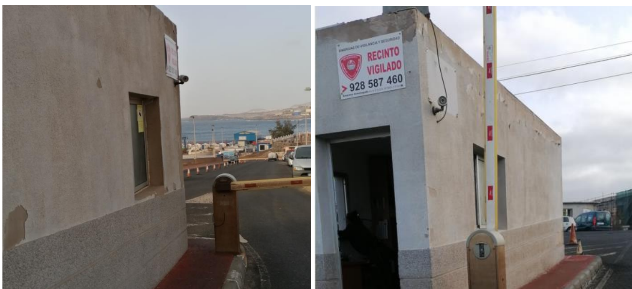
Fig. 5. Cámaras instalada actualmente en la entrada y salida del puerto.
