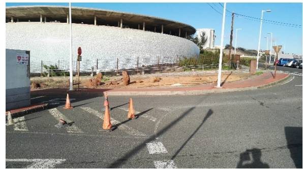
Foto 4. Zona caseta principal y comienzo tramo 2
