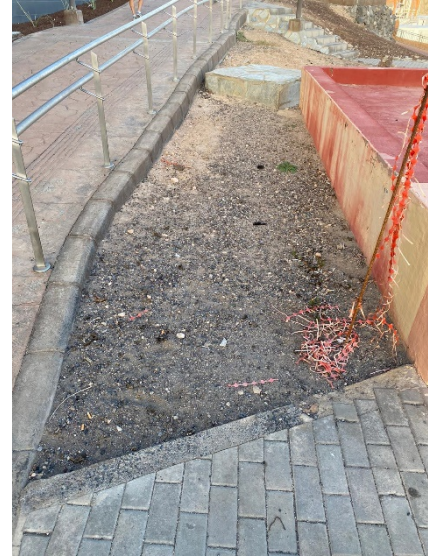
Foto 13. Zona de inicio de la rampa
