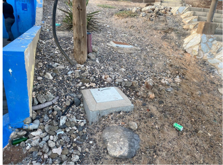
Foto 18. Contador red abastecimiento Foto 19. Tapas de arqueta entre las dos escaleras de acceso
