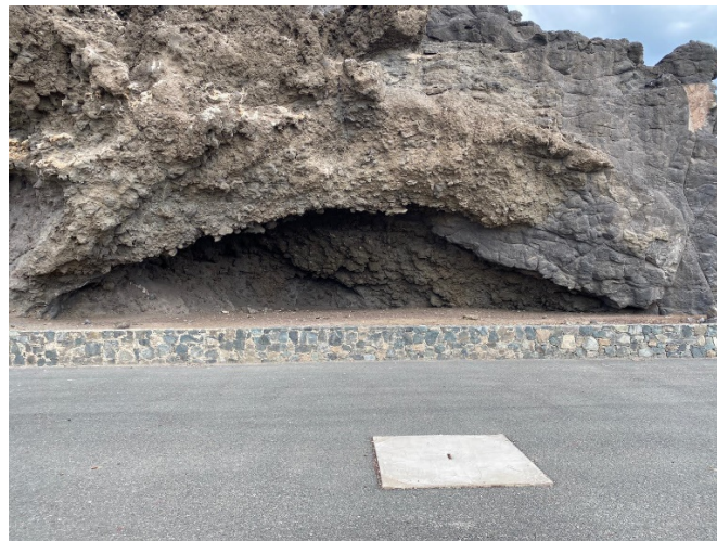
Foto 9. Estado actual zona vallado cueva
