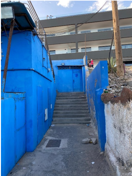
Foto 14. Parte baja acceso sur
