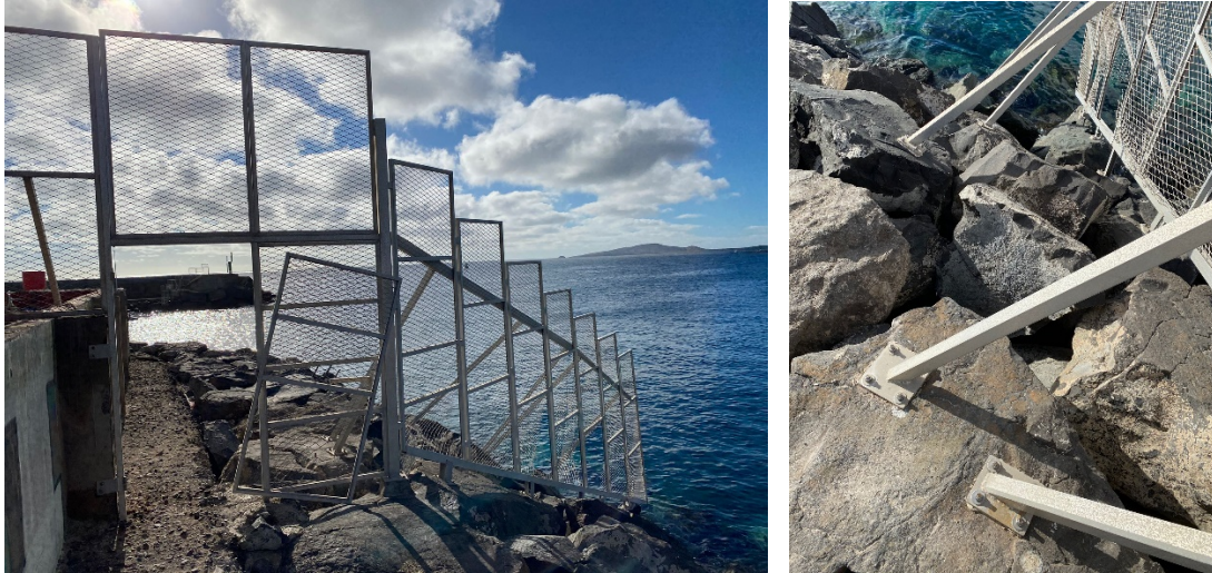
Fotos 7 y 8. Estado actual zona vallado escollera
