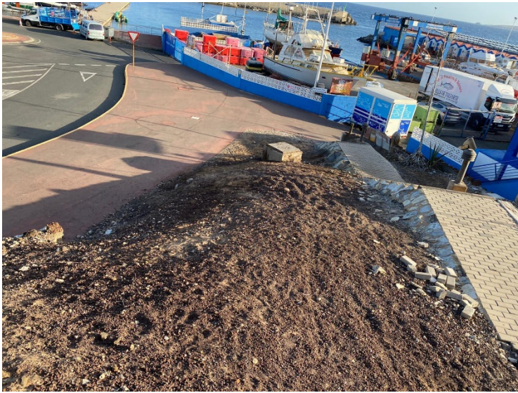
Foto 12. Terreno anexo a la escalera
