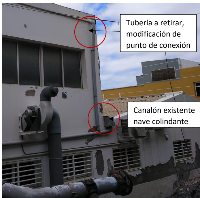
Ilustración 4. Red de Pluviales
