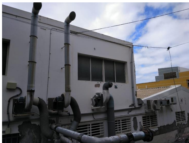
Ilustración 6. Servicios existentes en fachada a demoler
