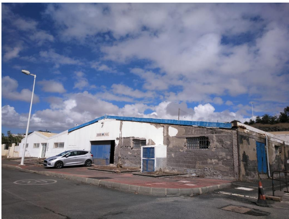
Ilustración 1. Estructura Nave Industrial
