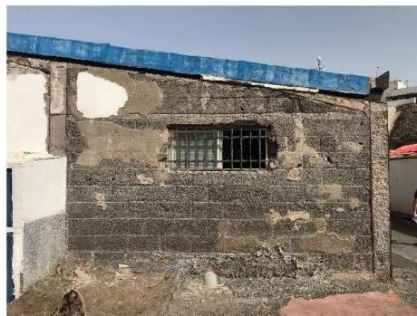
Figura V, VI: Estado de los muros y parte alta de la nave
