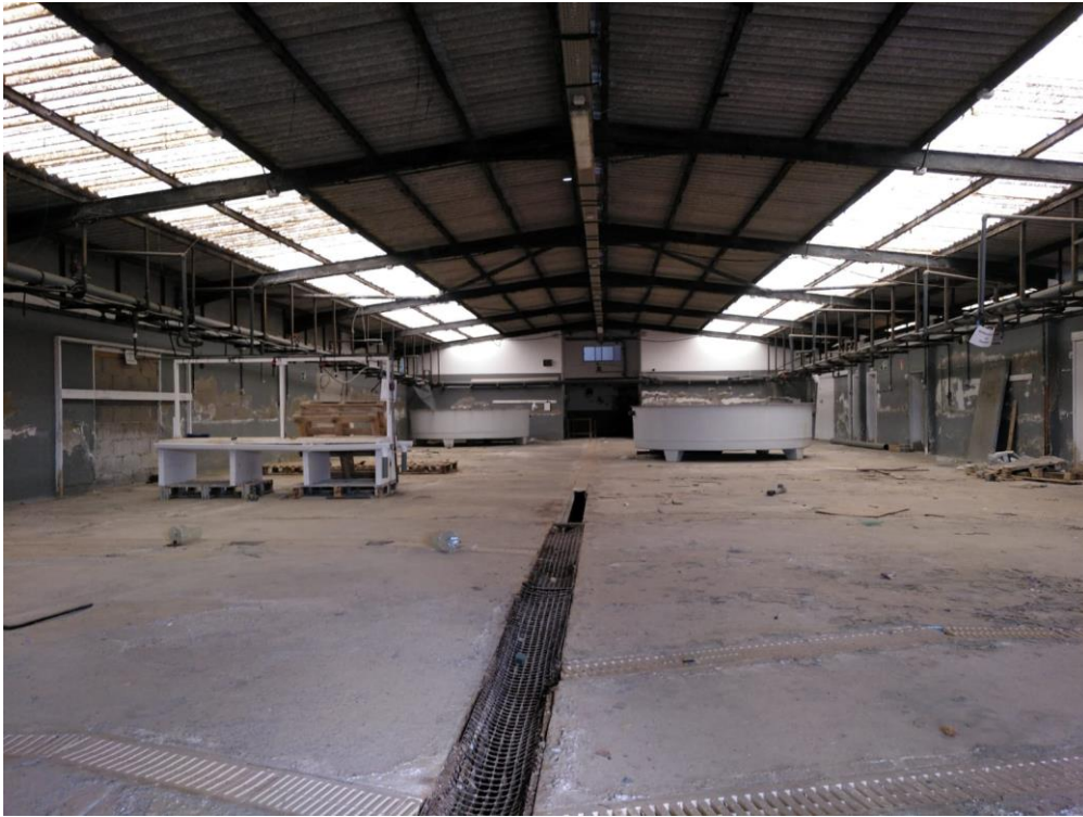
Ilustración 2. Estado Actual Planta baja, apreciación estructura metálica y tuberías de servicios
