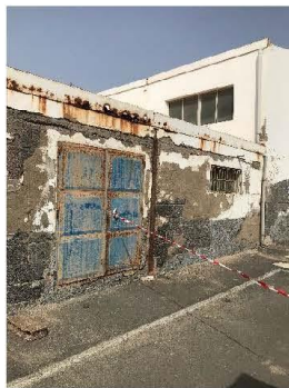
Figura III, IV: Estado de los muros exteriores
