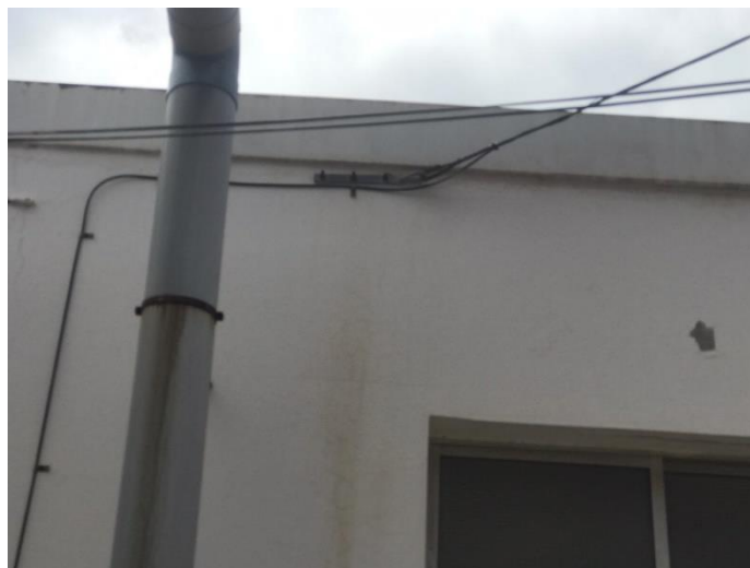
Ilustración 5. Apoyo Red de Telefónica
