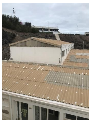
Ilustración 4 Exterior de la sala de juntas y biblioteca
