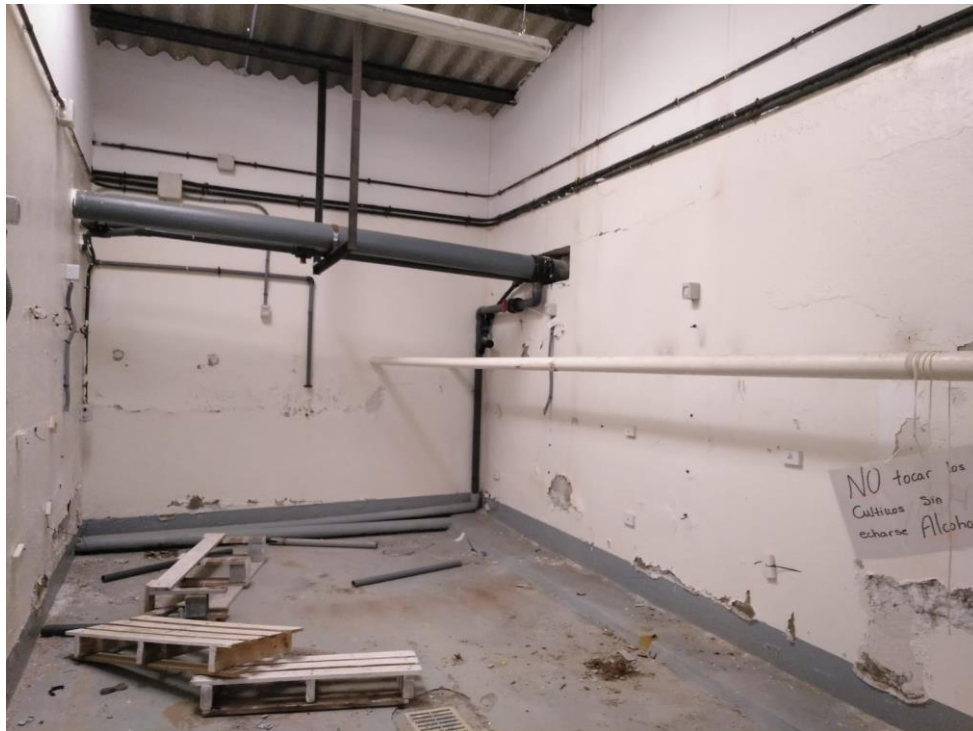
Ilustración 4. Habitación con presencia de tuberías y residuos, planta baja
