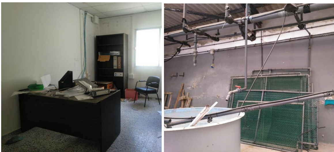
Ilustración 1. Ejemplo de residuos existentes en la nave industrial a demoler
