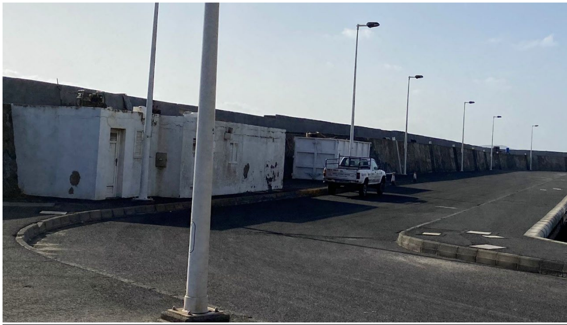
Estado actual de la zona a edificar
