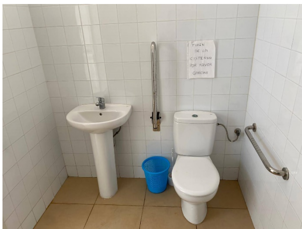
Baño de PMR actual
