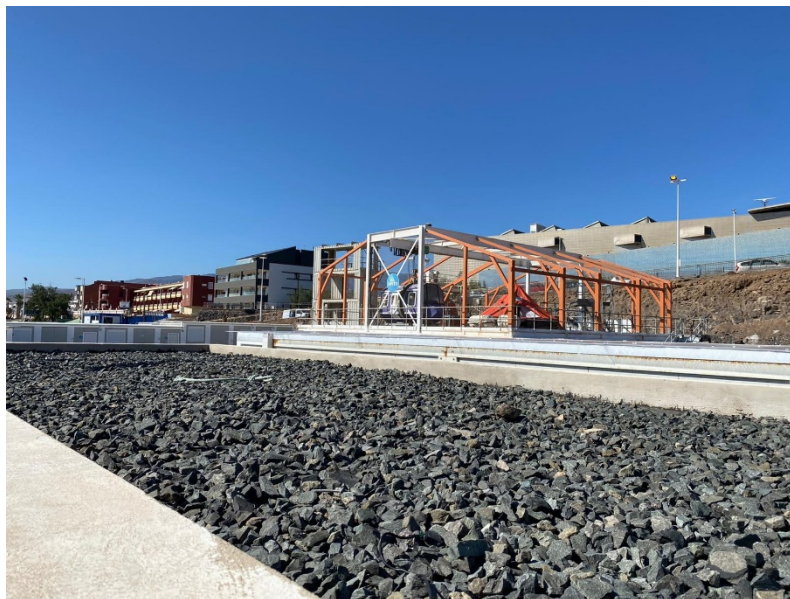
Cubierta de grava
