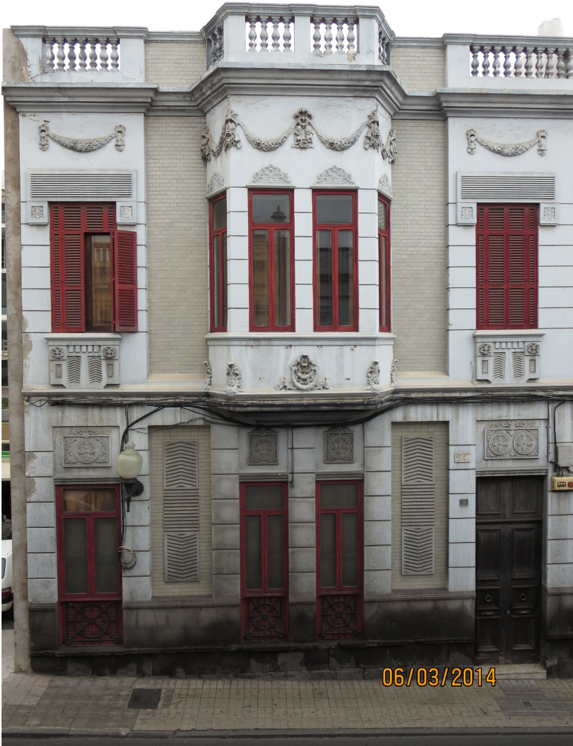
VISTA DE LA FACHADA PRINCIPAL
