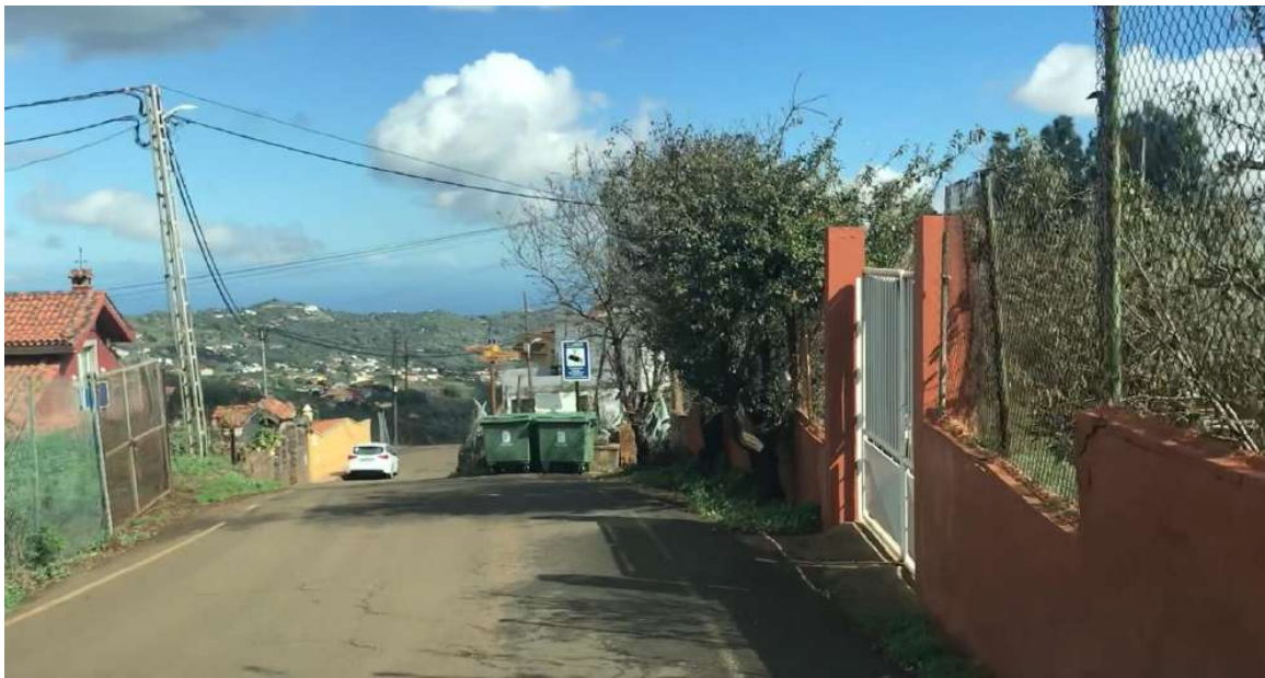
Foto nº2.- Servicios aéreos existentes. No existen aceras el acceso a las propiedades es directamente desde calzada.
