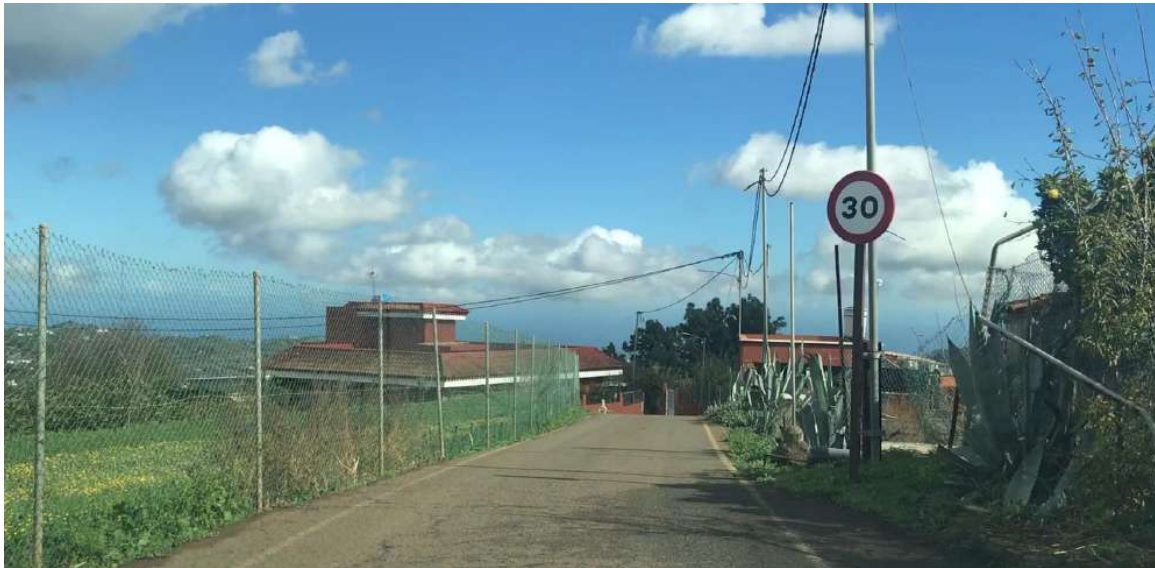
Foto nº1.- Comienzo del tramo de saneamiento a ejecutar. Pozo de cabecera coordinadas:
