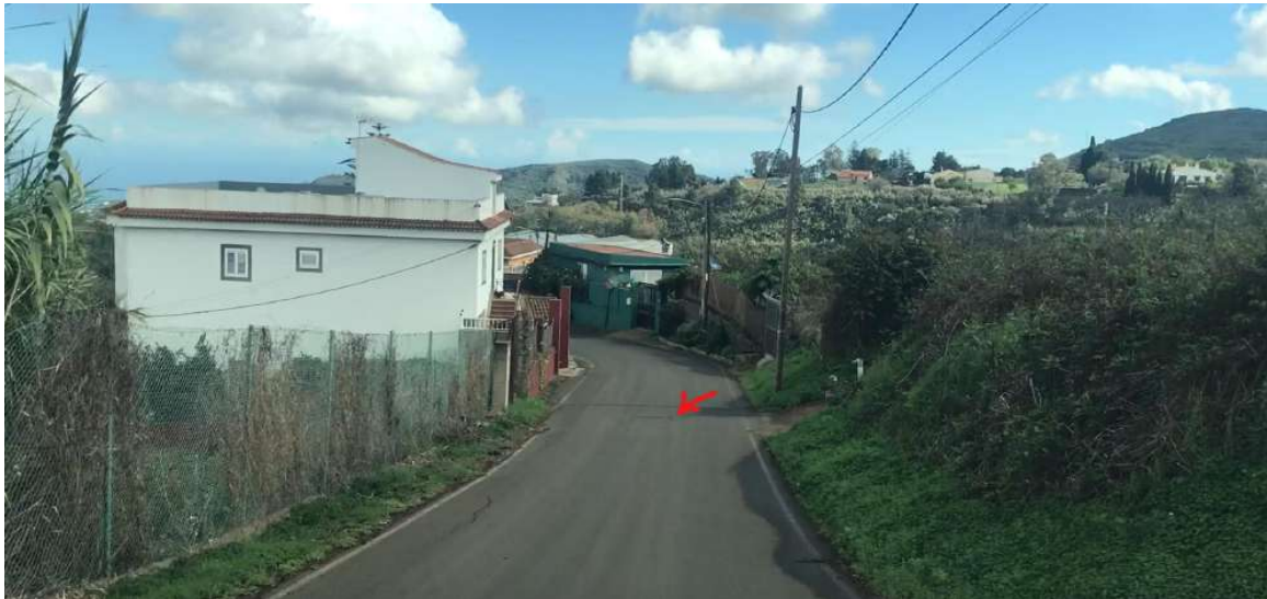
Foto nº5.- Pozo de conexión a la red existente.
