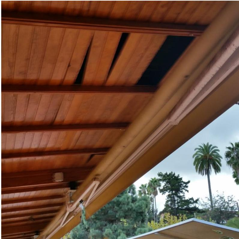
2.- Colocaciòn de falsa viga de 30x15cms en techo de madera de igual acabado y calidad para alojar en su interior instalaciones.
