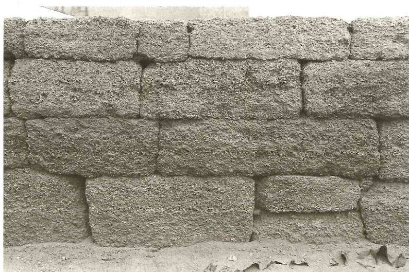
Foto 19. Detalle de uno de los paramentos construido exclusivamente con sillares de toba.
