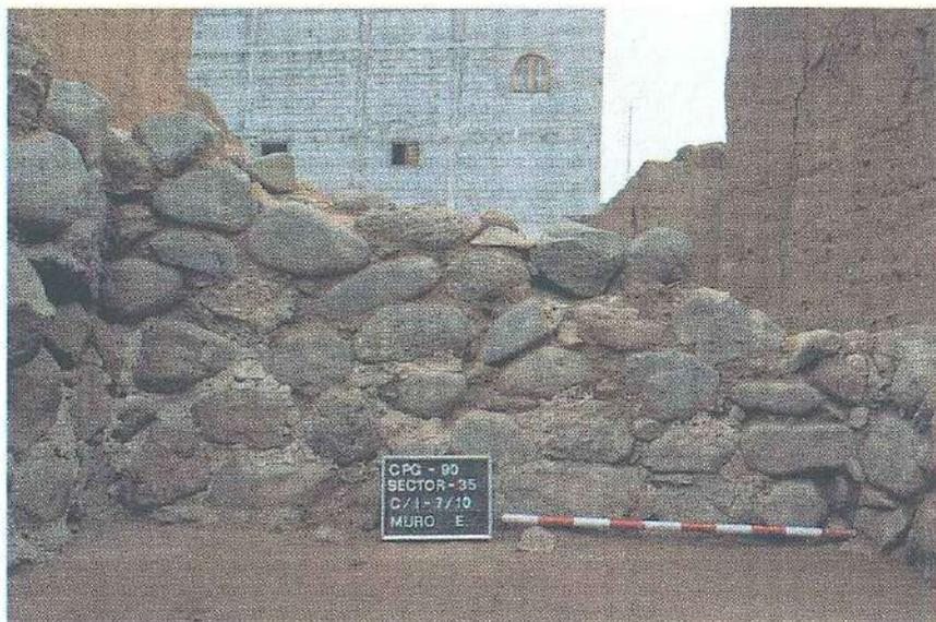
FOTO 8. Detalle de un muro de mampuestos de basalto con llagueado de mortero correspondiente a la alcoba derecha de una de las viviendas del caserío de la Cueva Pintada. Foto: J.I. Sáenz Sagasti.
