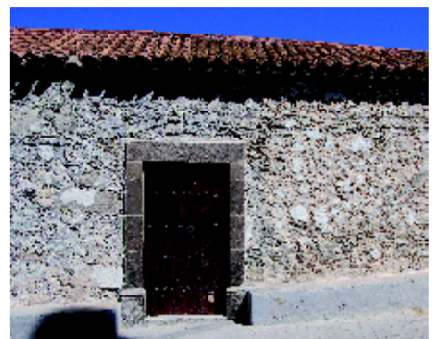
Arriba, Fachada principal y lateral sur de la ermita. De abajo, ventana de la actual sacristía, uno de los elementos más antiguos de la construcción. Abajo, las diferencias de la mampostería entre los muros de ambos lados de la puerta indican una ampliación del edificio.
