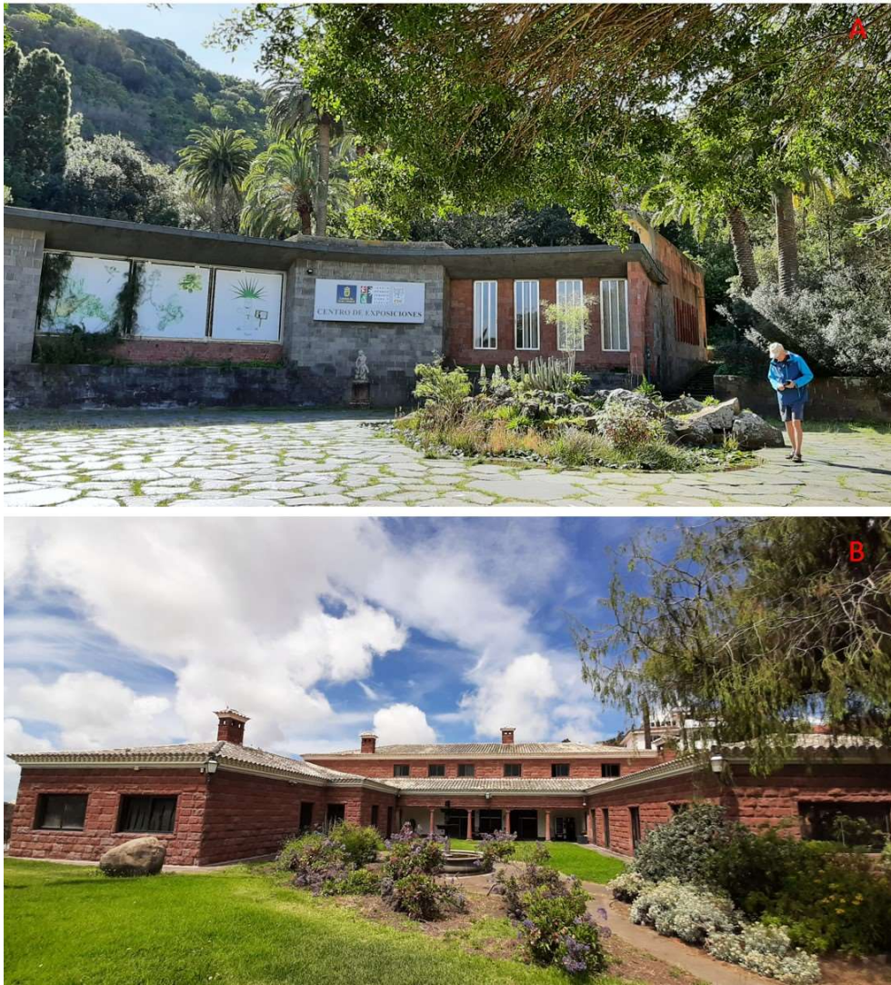
Figura 4. A) Casa y laboratorio de Erick R. Sventenius, construida hacia 1962, actual Centro de Exposiciones; B) Actual Centro de Administración y Laboratorios del Jardín Botánico Canario Viera y Clavijo, módulo principal (antigua casa-mansión del Dr. Stanley Pavillard). Fotos Á. Marrero.
