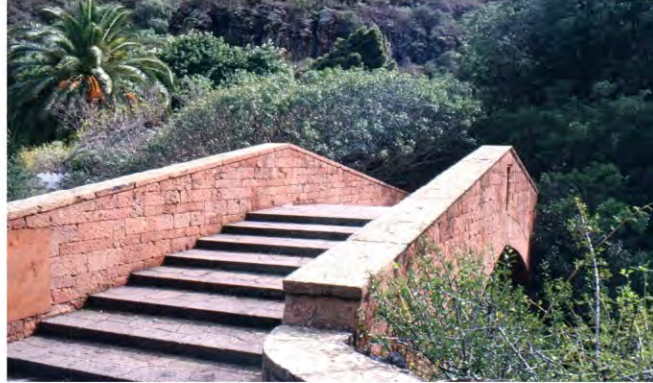
PUENTE DE PIEDRA (3)
