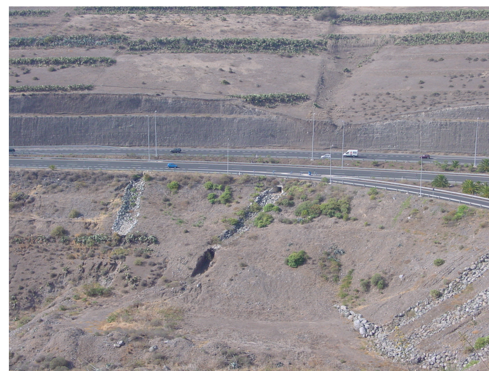
En la imagen superior, nuevo detalle de la ladera norte y en la inferior, una visión del talud de la GC-3, en el que se observan procesos erosivos provocados por la escorrentía de las aguas.
