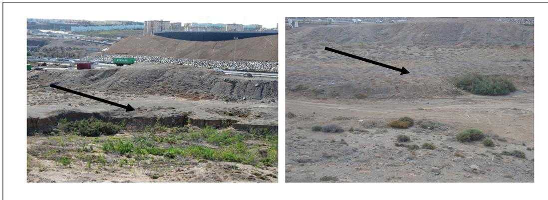
→ Para controlar la erosión en cárcavas se realizaron albarradas de piedra seca (restauración hidrológica).
