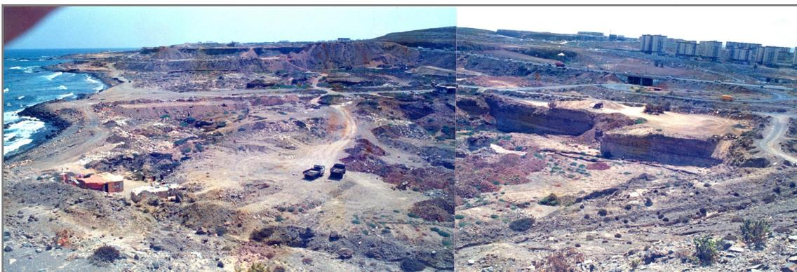
**Imagen 44.-** Cantera de extracción de arenas para la construcción en la trasplaya de Jinámar a finales de la década de los 80 del siglo XX. A la derecha de la imagen, restos de excavación que permiten observar el depósito sedimentario de 10 metros.
