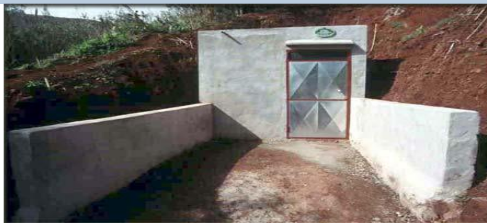
Elementos de las estaciones VSAT
