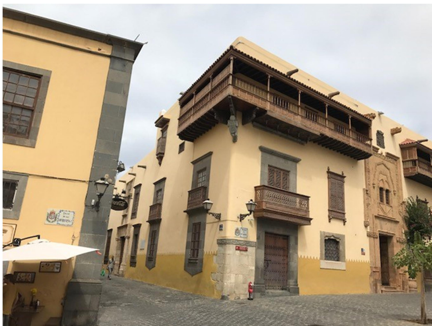
02.- Imagen de Balcón a restaurar
