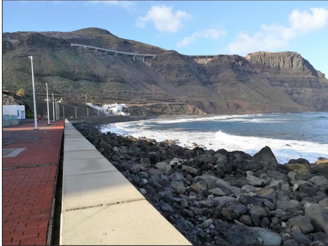
Ilustración 4. Panorámica del paseo desde su extremo oriental, donde se aprecia la escollera de protección existente.
