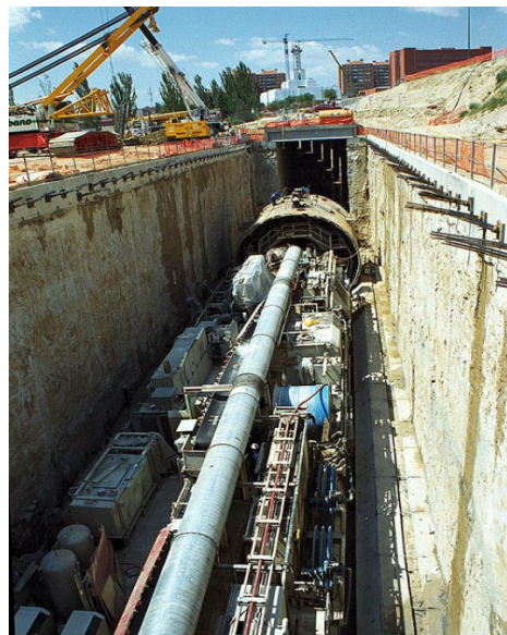
Foso montaje EPB
