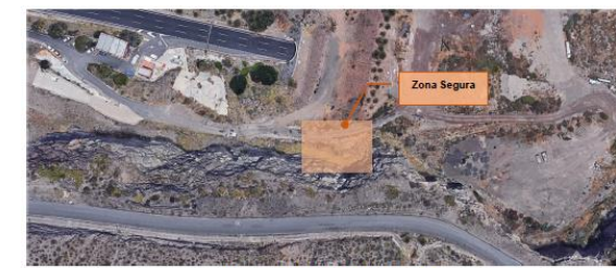
Zona segura 6 a la salida de SE Nº 6
