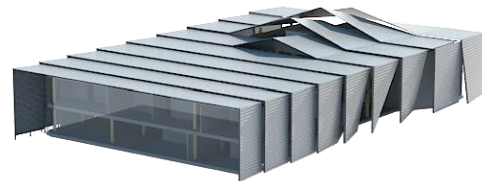
o Imagen exterior edificio de gerencia (fuente: PC Talleres, Cocheras y Área de Mantenimiento)
