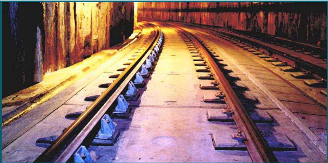
Imagen de losa prefabricada RAILTECH
