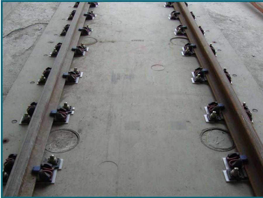
Placa prefabricada VPA/A
