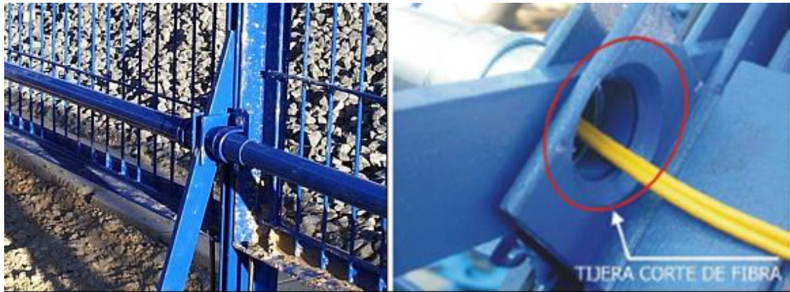
Ilustración 7. Detalle del tubo portante de la fibra
