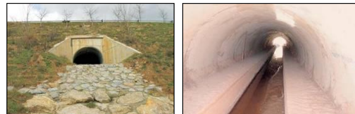
Ilustración 6.4. Ejemplos de adaptaciones en drenajes.
