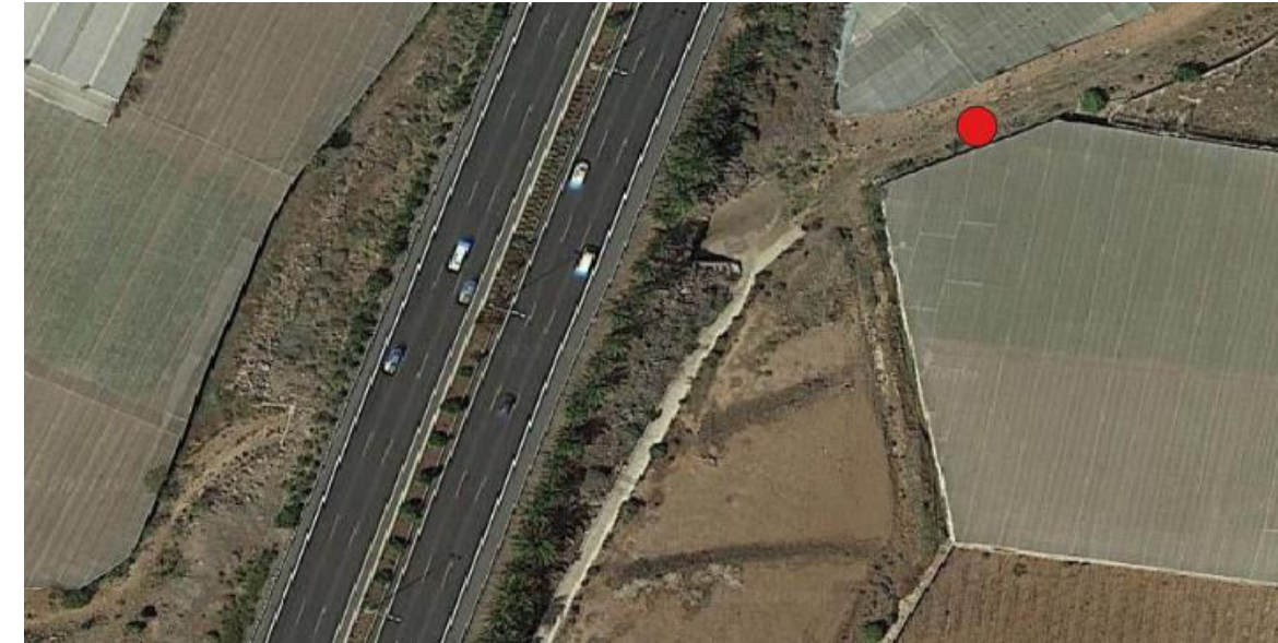
PPKK 29+400 Tramo 5. Fuente: Google Earth
