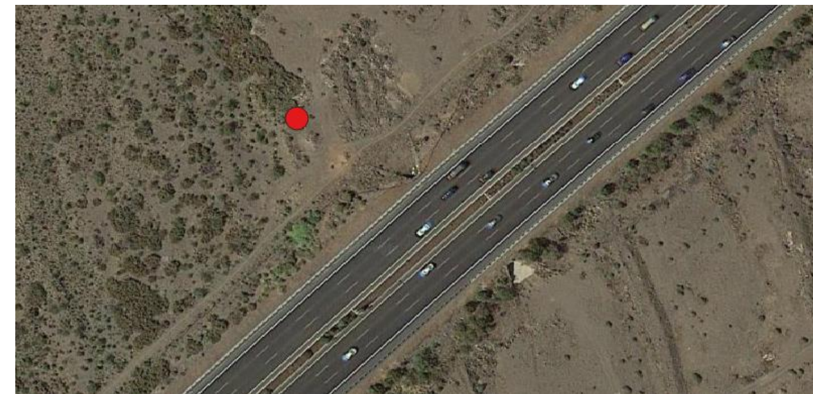
PPKK 40+900 Tramo 5. Fuente: Google Earth
