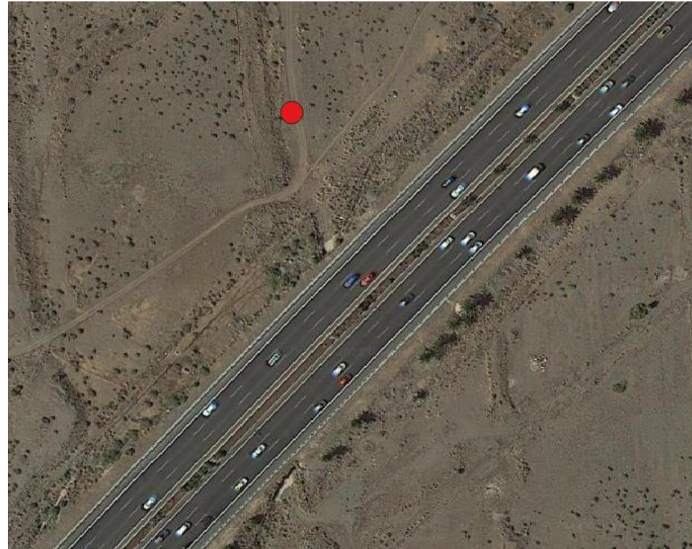
PPKK 41+250 Tramo 5. Fuente: Google Earth
