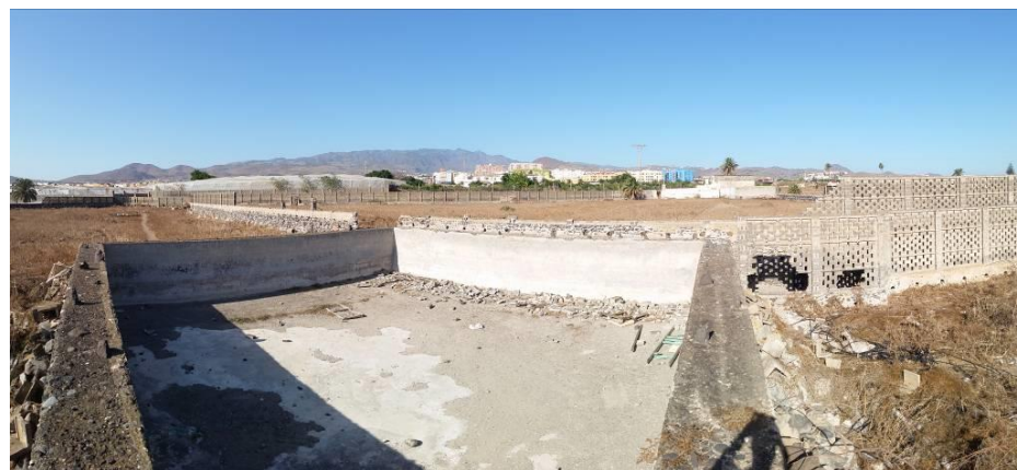
ETN-003: Vista general del estanque que forma parte de este conjunto hidráulico
