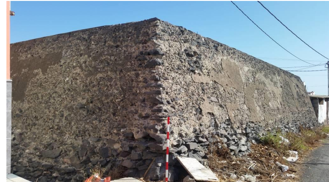
ETN-002: Vista general del estanque
