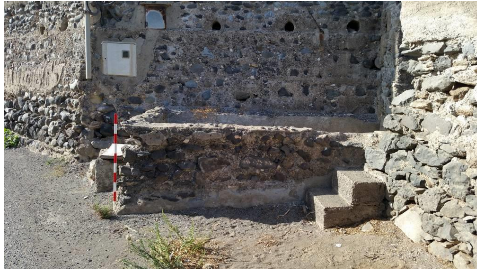
ETN-001: Vista general del rebosadero
