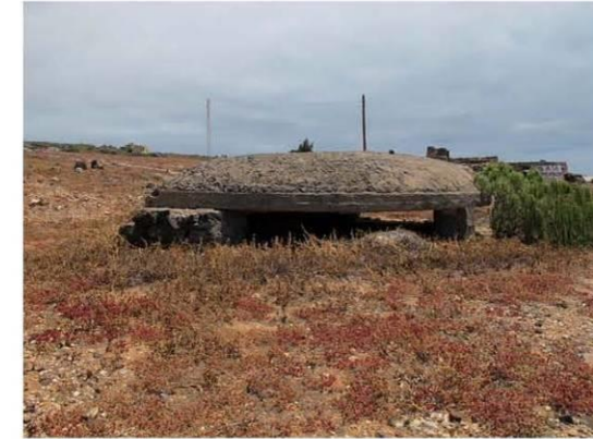
Estudio del Patrimonio Histórico del Proyecto Básico y Constructivo de Plataforma de la Línea Ferroviaria entre Las Palmas de Gran Canaria y Maspalomas. Tramo 4: Polígono Industrial El Goro – Barranco de Guayedeqe
