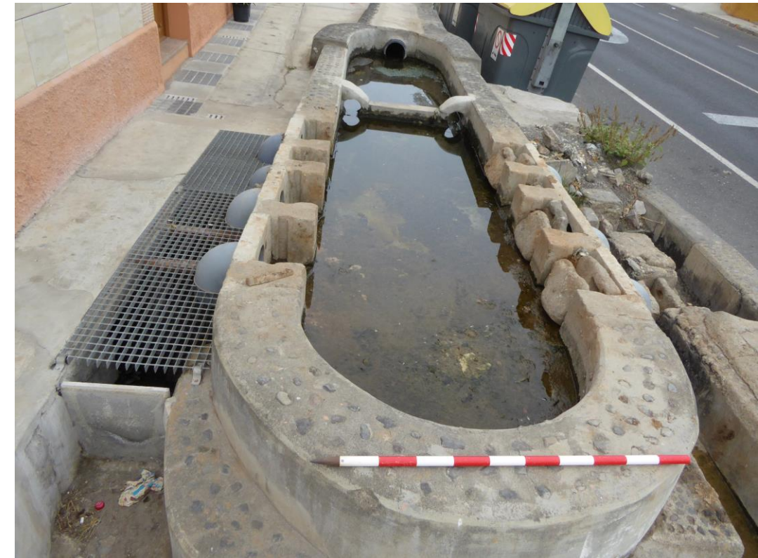
ETN-006: Imagen actual de la cantonera. En esta toma se pueden apreciar los tubos de PVC que se han instalado en las troneras.
