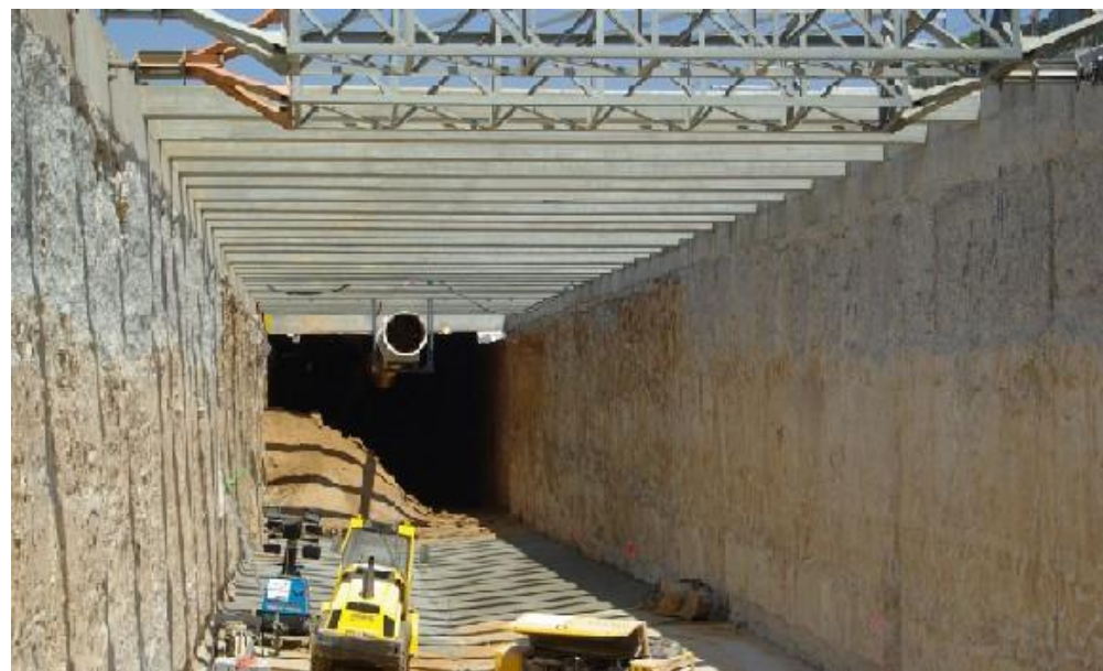
Túnel artificial entre muros pantalla
